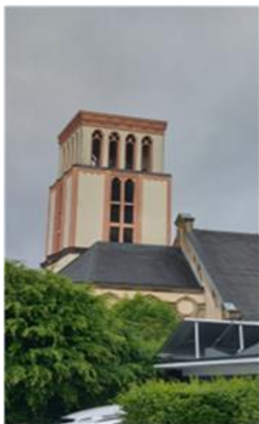
Turm ohne Dach
