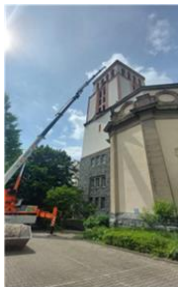
Erste Maßnahme – Abdichten des offenen Daches
